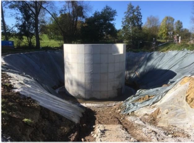
Pour **INFORMATION** un bassin d'orage (BO) a été construit sur le ban de la commune sur la route de Veckersviller. C'est un ouvrage de 6 m de diamètre et de 6 m de profond partiellement enseveli, servant à canaliser et réguler les arrivées et départs des eaux usées vers la station d'épuration de Weyer, lors de fortes précipitations, afin d'éviter au maximum les surverses dans la nature comme c'était le cas auparavant.
